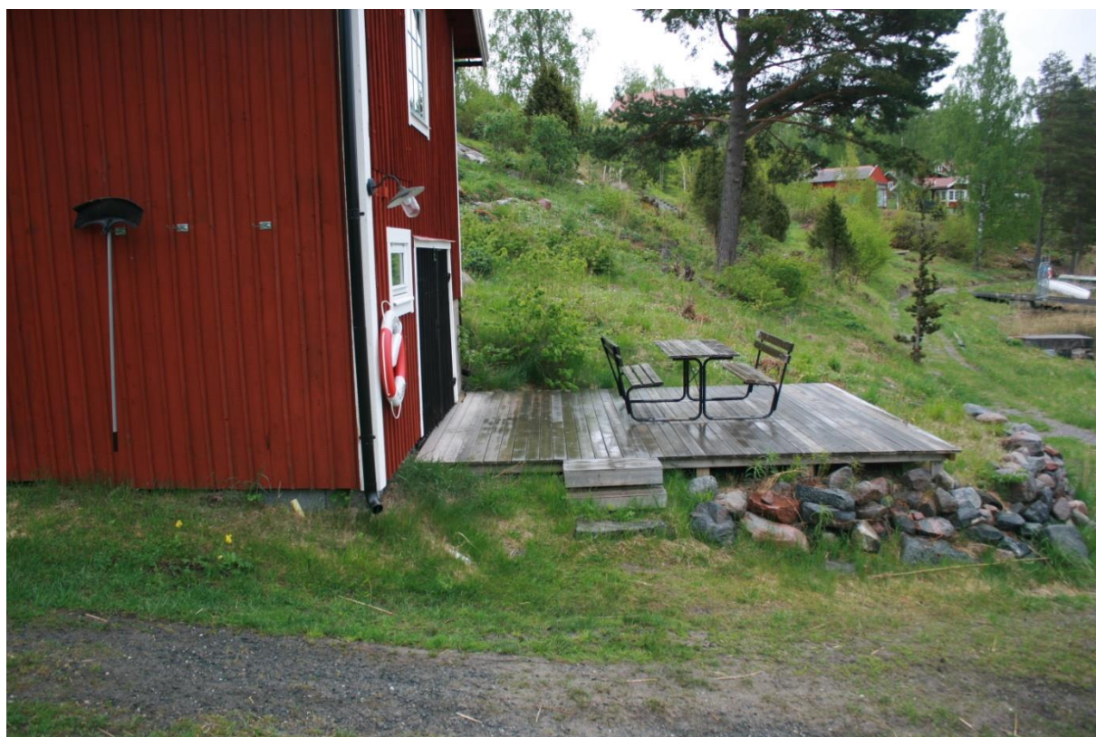
Västra gaveln på båthuset med ingången till bastun. Foto: författaren.
