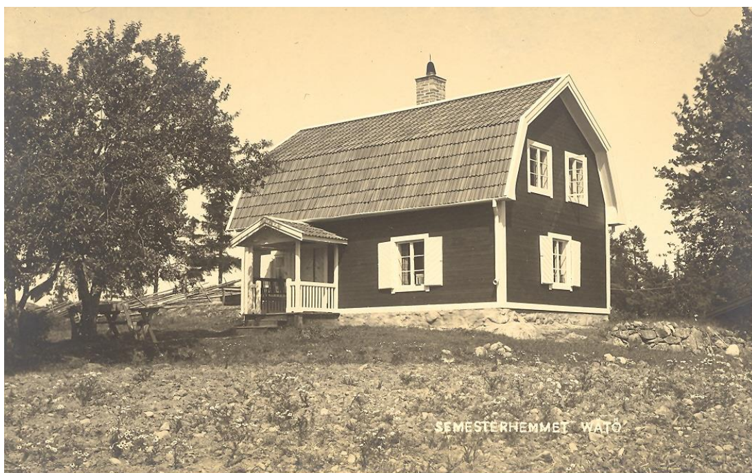
Torpet Tallen efter renovering. Bild: Vykort från Vätö Hembygdsförening.
