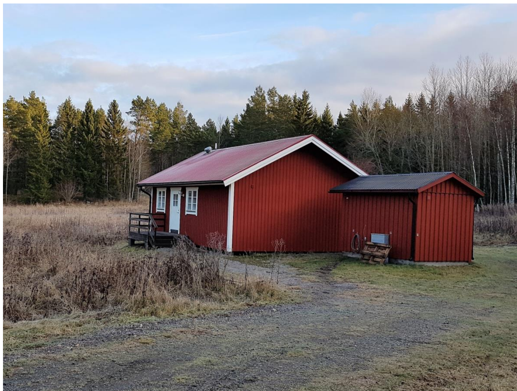
Servicehuset och det lilla vattenverket. Foto: författaren.
